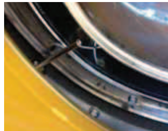
Schweißnähte von Schweißroboter werden 100 % kontrolliert
